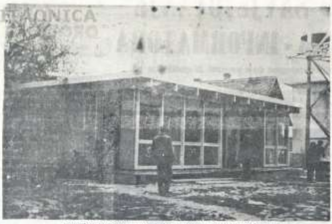
ZAVRŠNI RADOVI na podizanju veterinarske apoteke u Vinkevcima.
